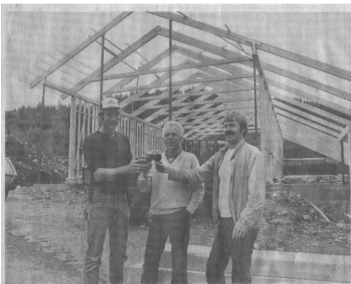
Vi er godt fornøyd med arbeidet hittil, skåler Harald Idland fra venstre, Odd Vegard Nedrebo og Magne Vaule fra byggekomiteen for nytt samfunnshus i Bjerkreim.
